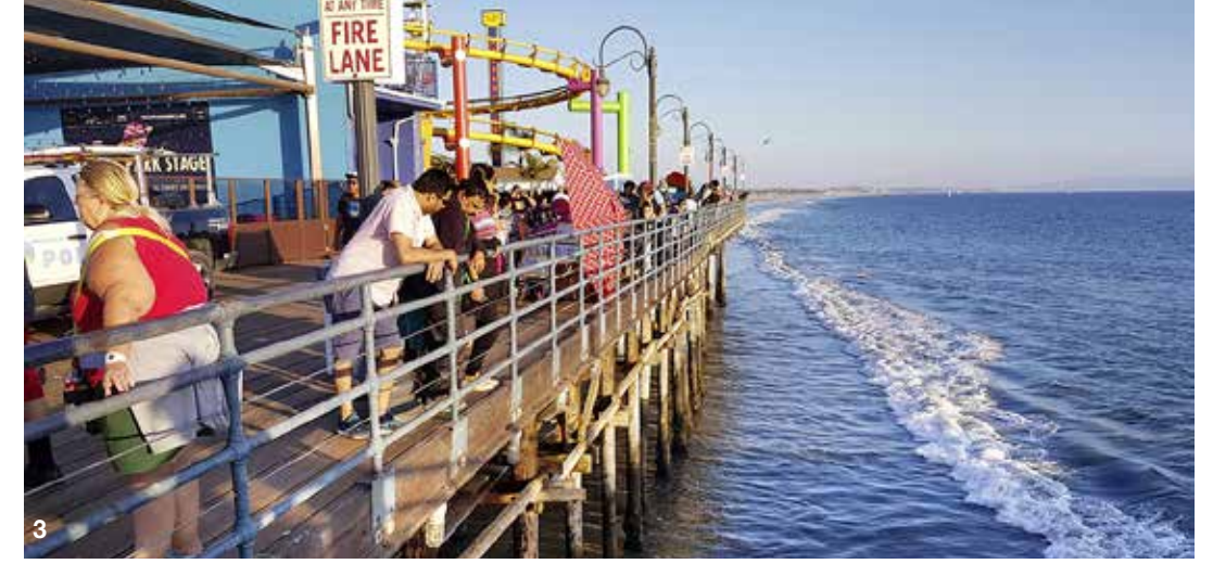
1, 2 산타 모니카 해변 전경 3 산타 모니카 피어(잔교)
